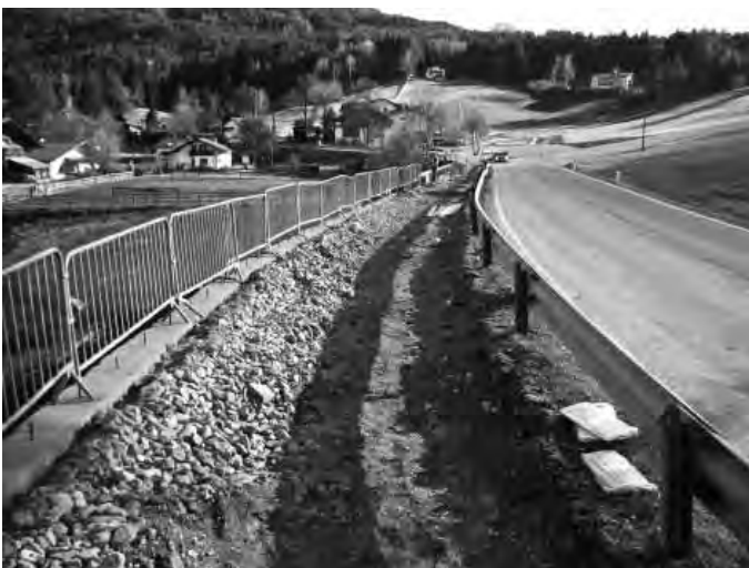
An der Landesstraße entsteht ein Radweg
