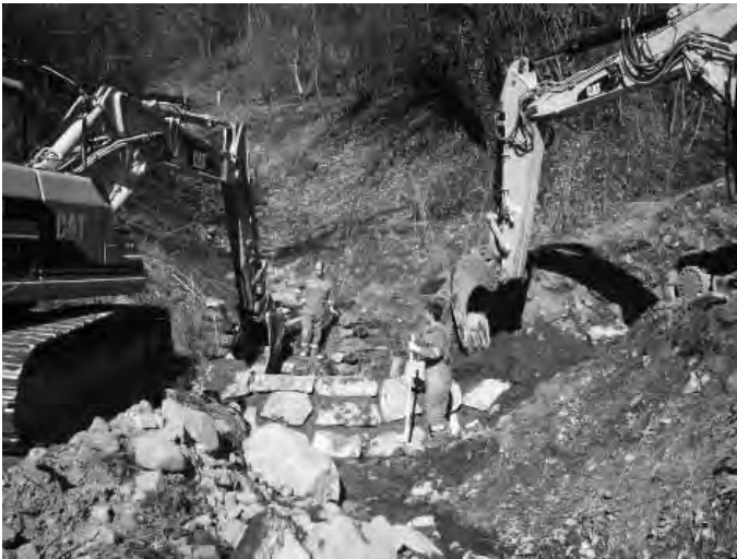
Baustelle an der Weiherstraße
