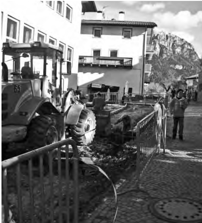
Die Baustellen verlangen den Anrainern etwas Geduld ab.
