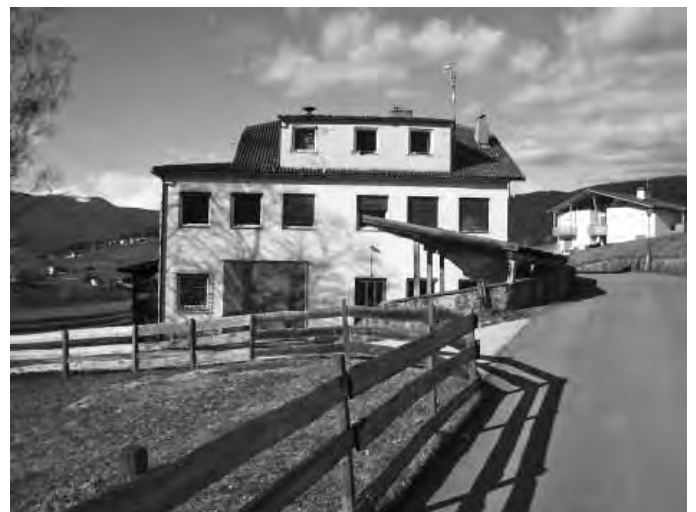
Das alte Schulhaus in Ums wird abgerissen
